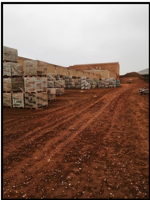
Figura 20. Figura del almacén de producto terminado 02.
