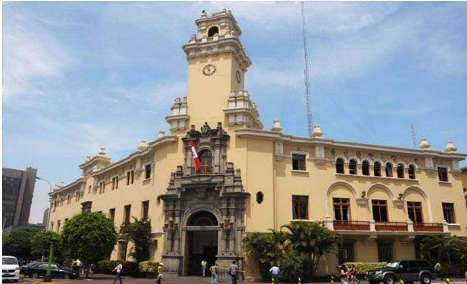
Figura 7. Palacio Municipal de Miraflores . Fuente: Municipalidad de Miraflores
