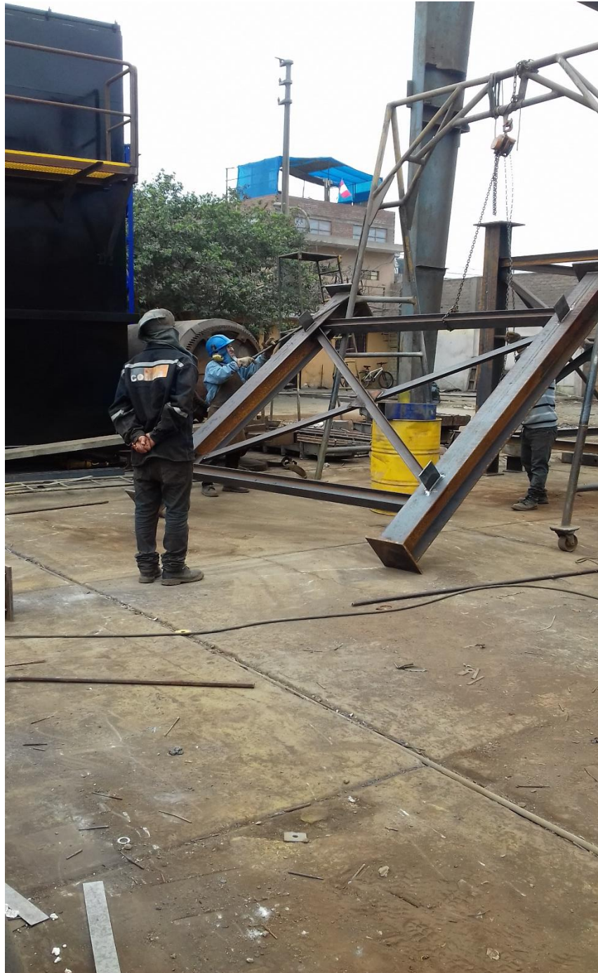
Supervisión del anclaje de la estructura
