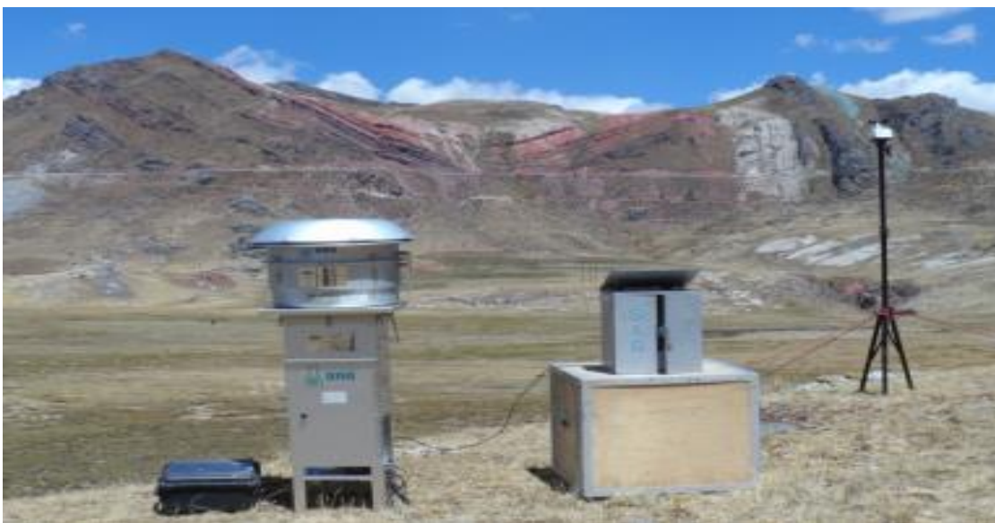
Figura 14. Instalación de equipos para el análisis de aire y emisión gaseoso, Fuente: Propio
