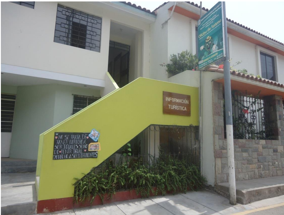
Figura 38. Fachada de oficina de información turística de Callahuanca. Foto: Daysi Bernales
