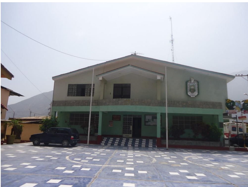
Figura 53. Municipalidad distrital de Callahuanca. Foto: Daysi Bernales
