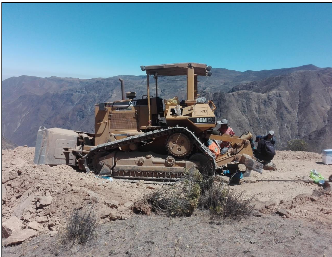
Figura 9: Inicio de obra. Fuente: Municipalidad de Mariatana.
