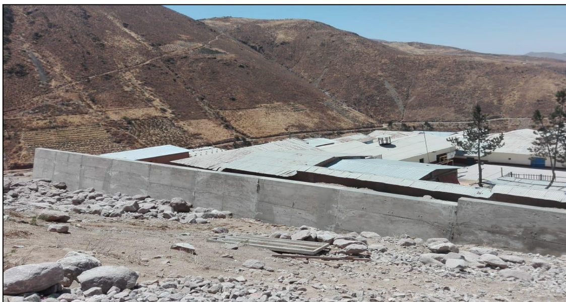
Figura 11: Muro de contención en Calaguaya. Fuente: Municipalidad de Mariatana
