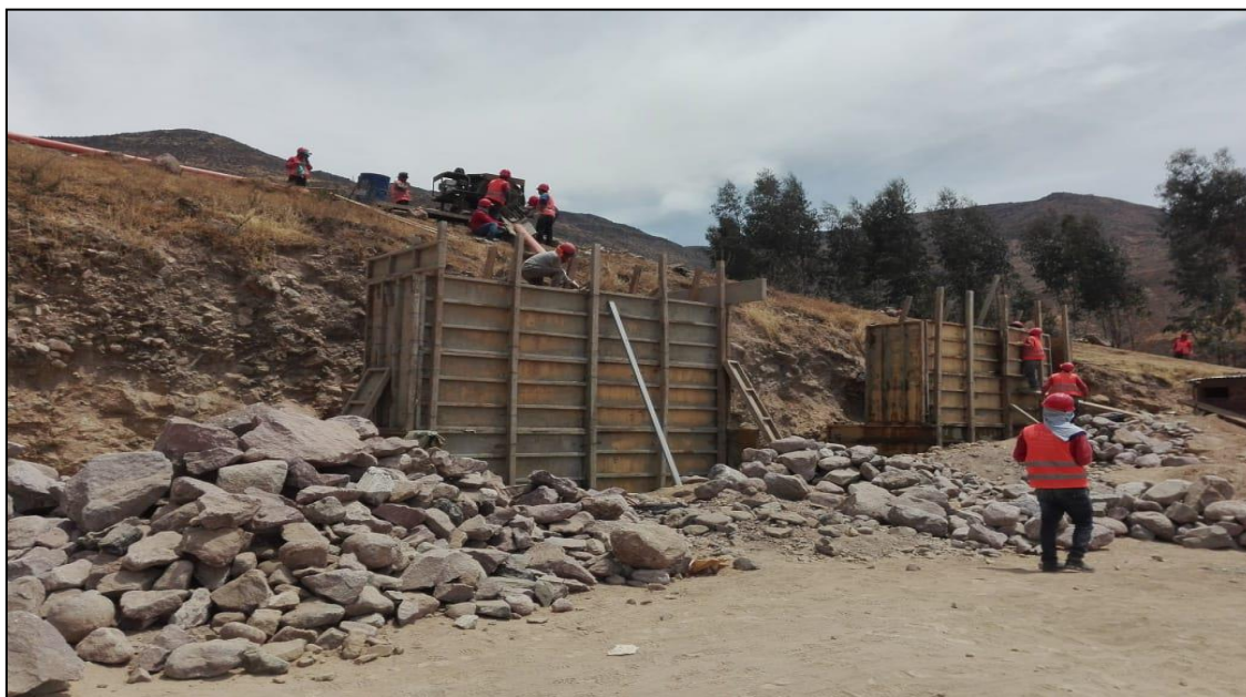
Figura 12: Muro de contención en Cuculí. Fuente: Municipalidad de Mariatana
