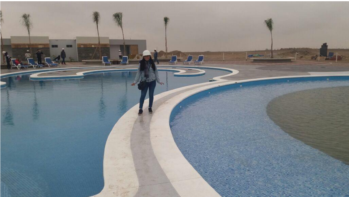
La contadora en medio de dos piscinas recién construidas de la empresa.
