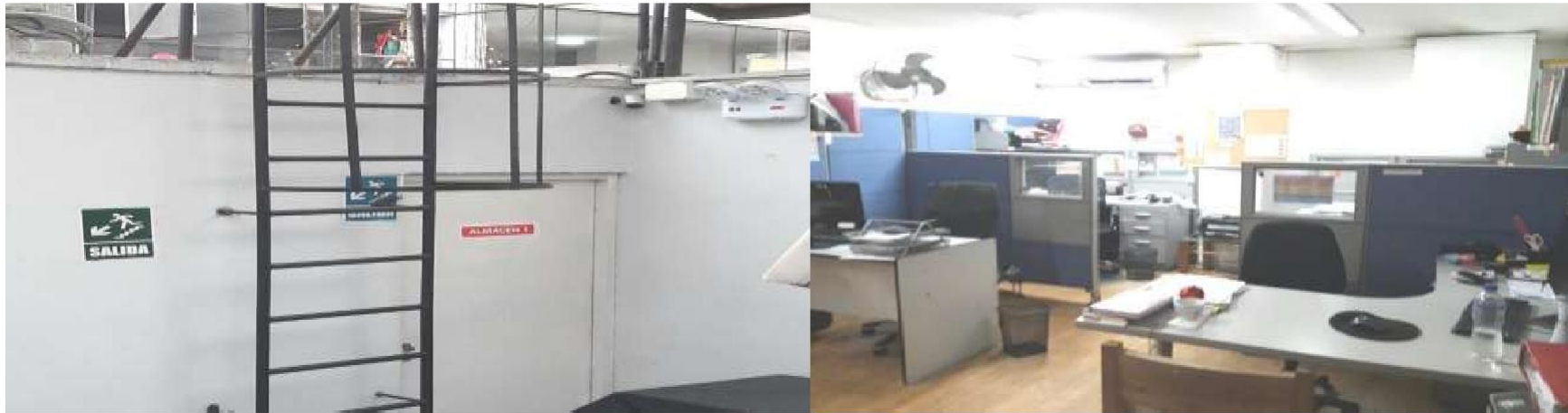
Area de almacén y administrativo.
