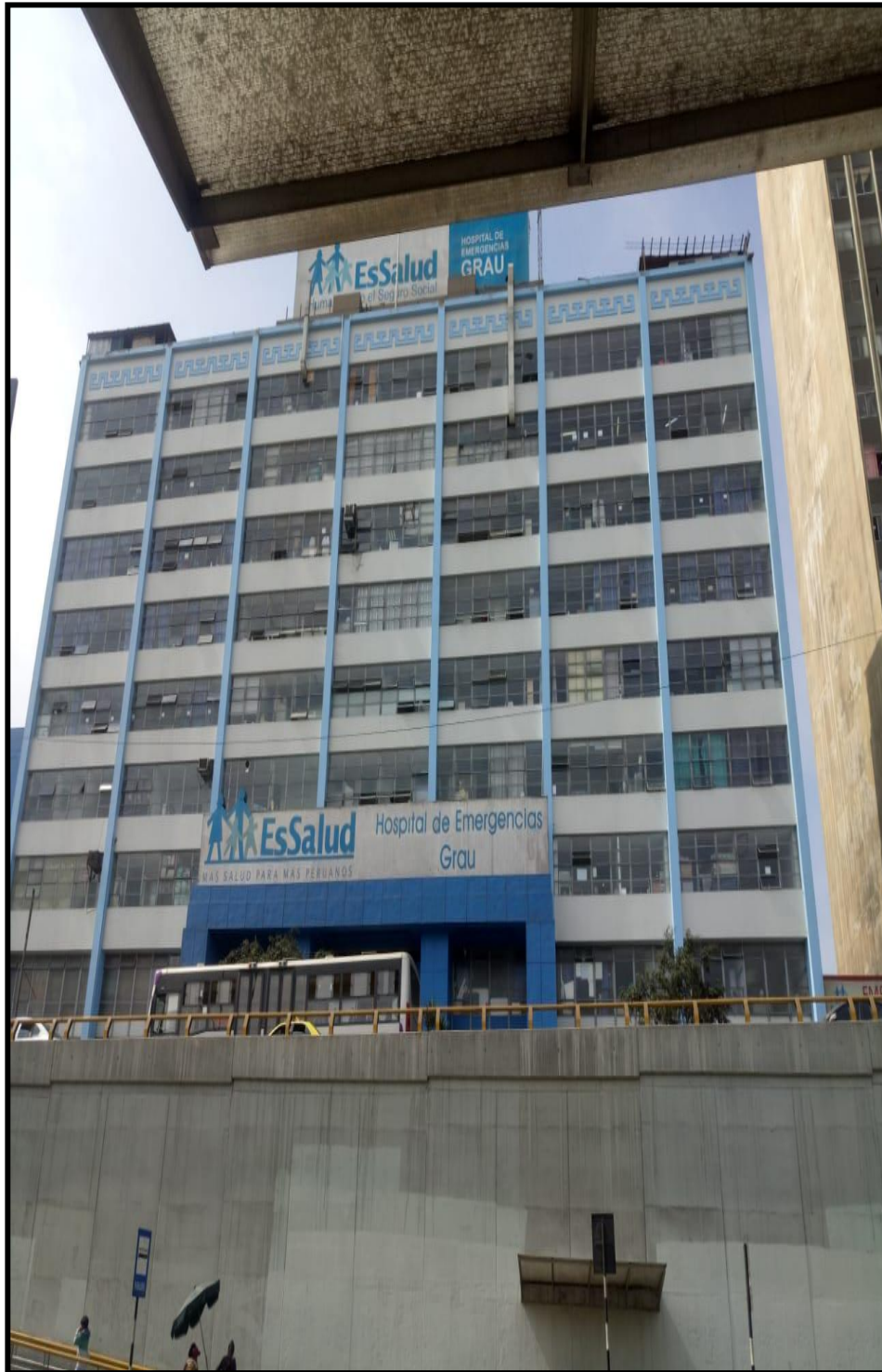
Anexo Ñ. Vista frontal del Hospital III Emergencias Grau Essalud 2018.
