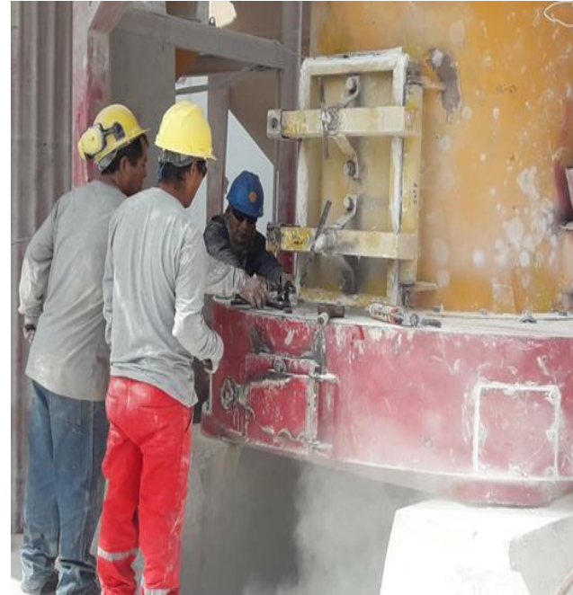
Molino de rolas en mantenimiento
