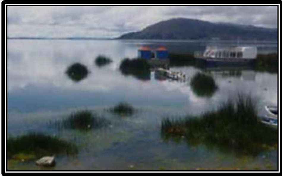
Figura 5. Instalación de los aireadores de la Bahía Interior de Puno. 33
