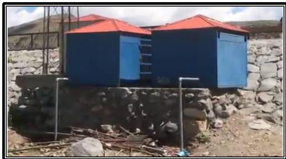
Figura 6. Instalación de motores y soplador (base 5). 33
