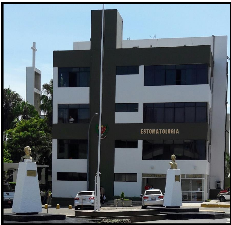
Edificio de estomatología
