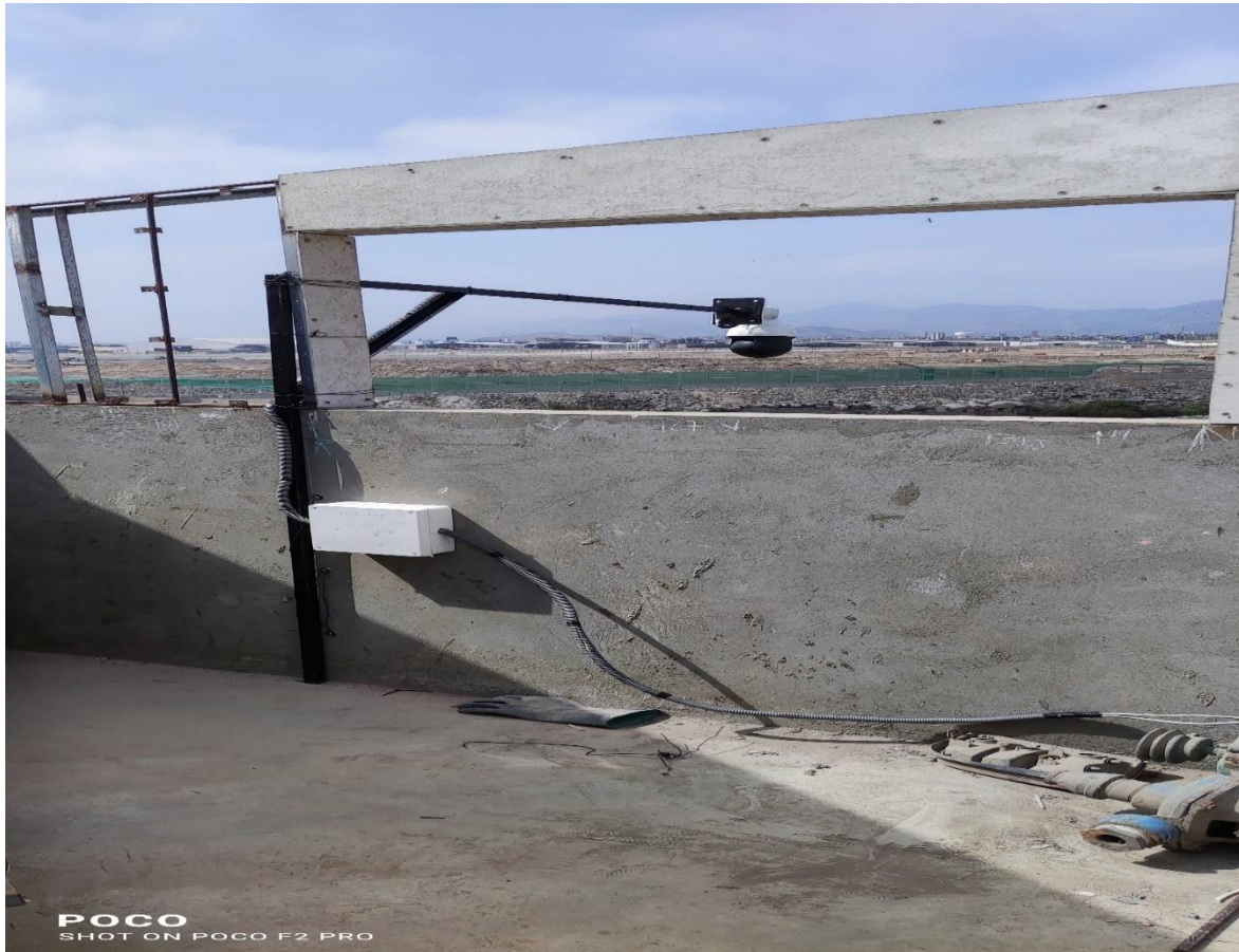
Figura 10 Instalación de brazos y soportes metálicos.
